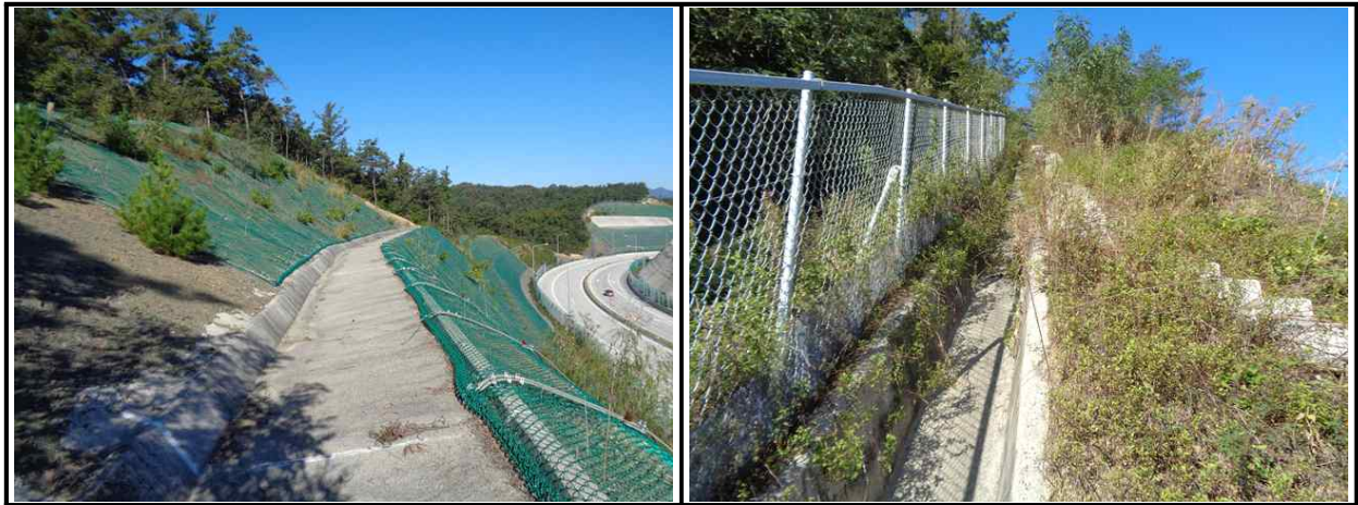
【그림 59.3.3】 배수시설 전경
